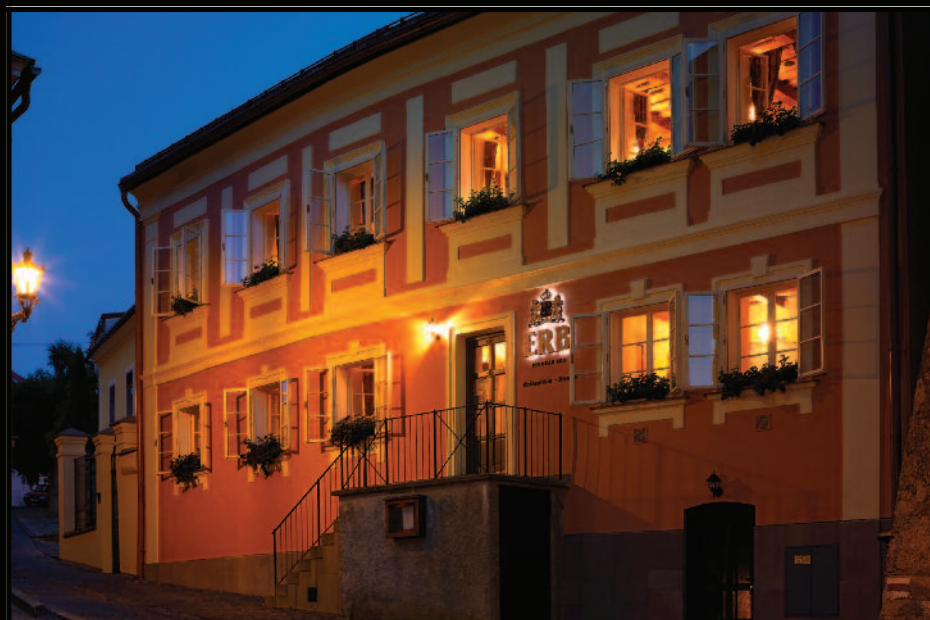
Budova Pivovaru ERB v historickom centre Banskej Štiavnice
